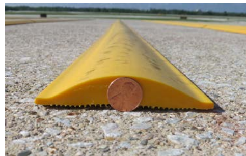
(d) The 4" Raised Rumble Strip Profile
